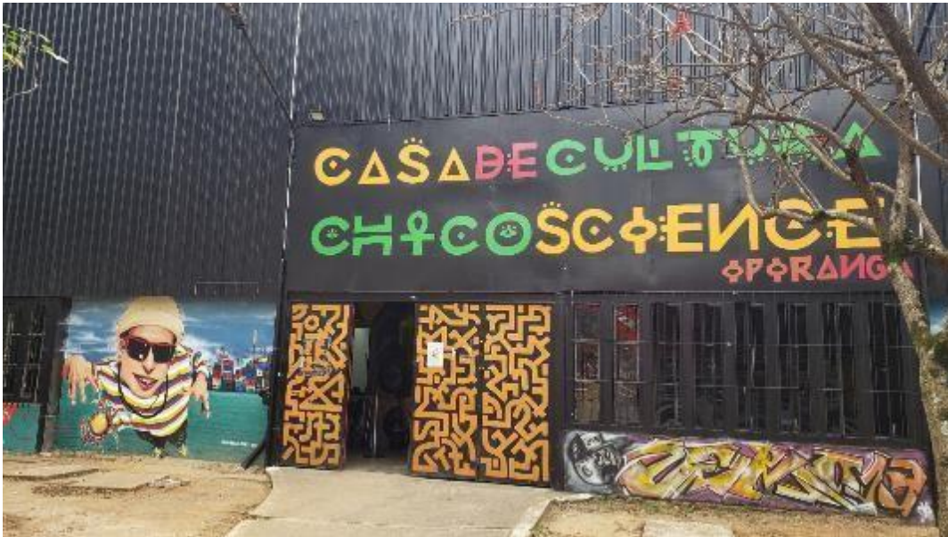
Figura 111 - Fachada - Casa de Cultura Ipiranga
