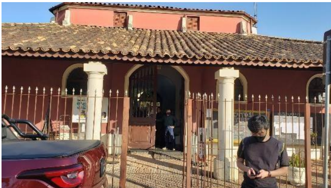
Figura 106 - Fachada - Casa de Cultura Manoel Mendonça
